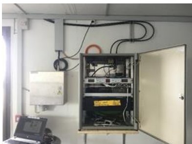
Innenleben und Antenne DMR-Repeater Hoher Kasten
